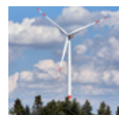
Frickenhofer Höhe II 3,6 MW Leistung, in Betrieb seit 2019
