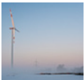
Ketzin 8 MW Leistung, in Betrieb seit 2009
