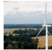
Soltau 3,9 MW Leistung, in Betrieb seit 2006
