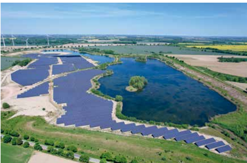
Der Solarpark in Wusseken in Mecklenburg-Vorpommern.
