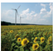
Buchhain II 6 MW Leistung, in Betrieb seit 2012
