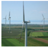
Parndorf II (Österreich) 5,7 MW Leistung, in Betrieb seit 2004
