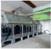
Haßfurt 1,3 MW Leistung, in Betrieb seit 2016
